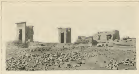
FIG. 442. — LE TEMPLE DE DÉBÔT AVANT LA RESTAURATION. (Cliche E. Brugsch.)
